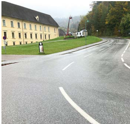
Übergang beim Stift Rein. Bessere Markierung zur Sicherheit der Fußgänger notwendig.
